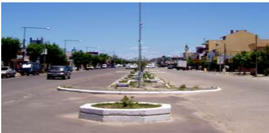
Figura 2: Avenida internacional Chuí - Chuy
